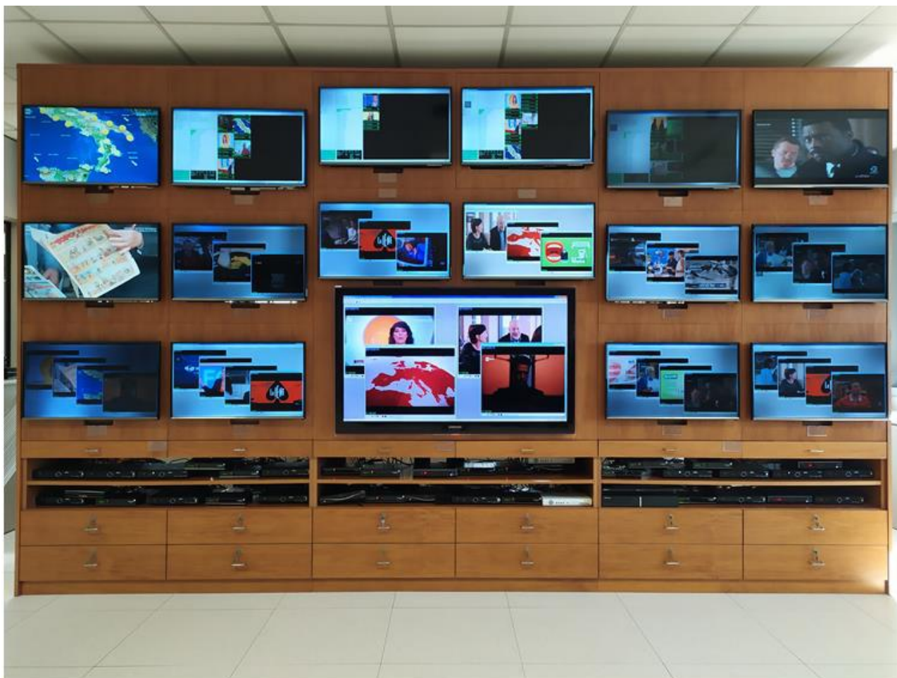
Figura 4 – Panoramica sala TV
